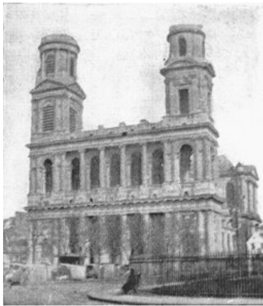
FIG. 183.—FAÇADE OF ST. SULPICE, PARIS.
